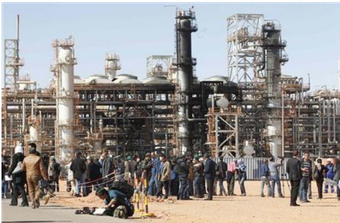
＜写真 1-3-9＞被害にあったプラント
