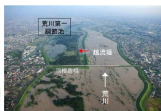
平成19年9月の洪水調節状況(調節池上流から)
