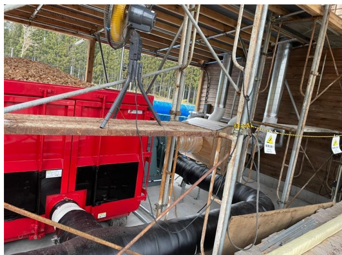
熱をチップ乾燥に用いる事例(宮城県大崎市、WSA撮影)
