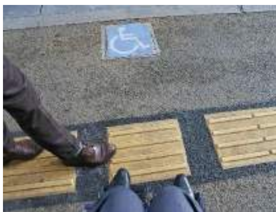
図 16 スリット入り点字ブロック（長崎県佐世保市） 124
