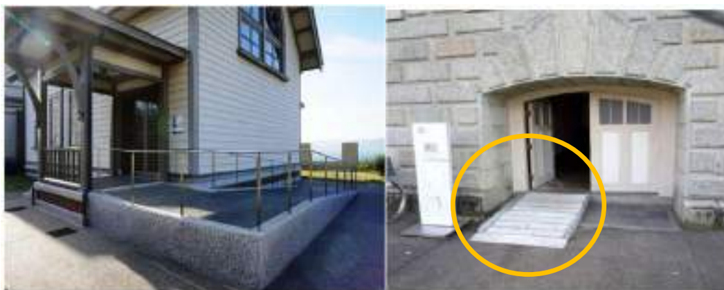
図 40 一般的なスロープ（左・兵庫県）と簡易スロープ（右・山形県） 212
