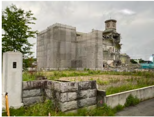
図 24 解体が進む大熊町図書館・民族伝承館（大熊町） 128
