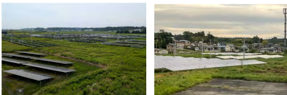
図 16：小高区の太陽光発電設備 151
